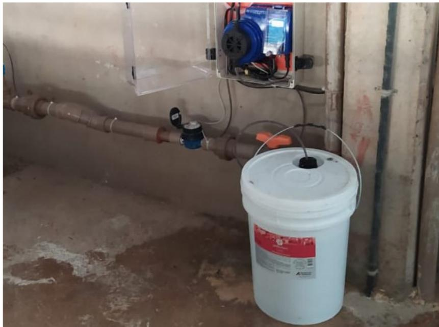
Equipamento instalado na CPS da ACSURS para acidificar a água.
